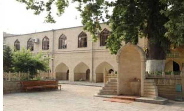
Здание медресе после реставрации
